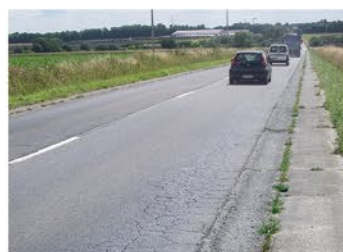
Vieillesse d'un enrobé bitumineux.
