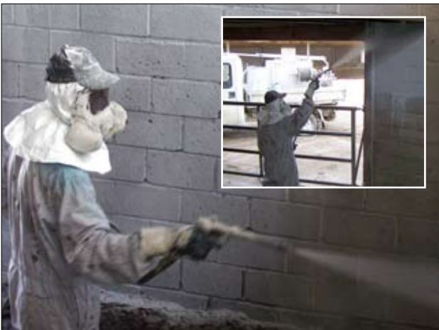
Figura 5: Ejemplo de encalado de un establo con lechada de cal. La lechada de cal puede también aplicarse por cepillado u otras técnicas (Bélgica).
